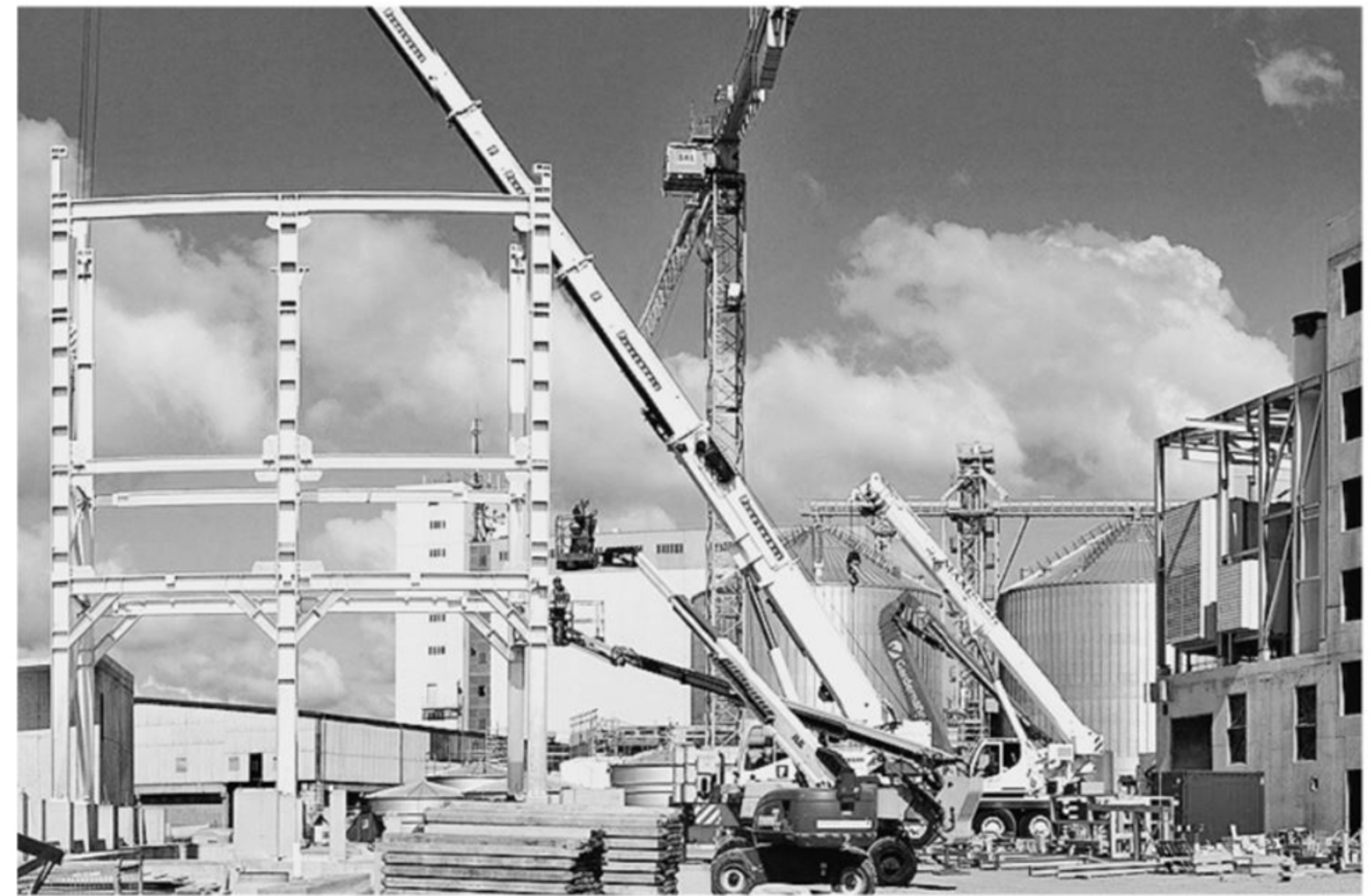
Digitales Baustellenmanagement spart Zeit, die für andere Aufgaben verwendet werden kann.
