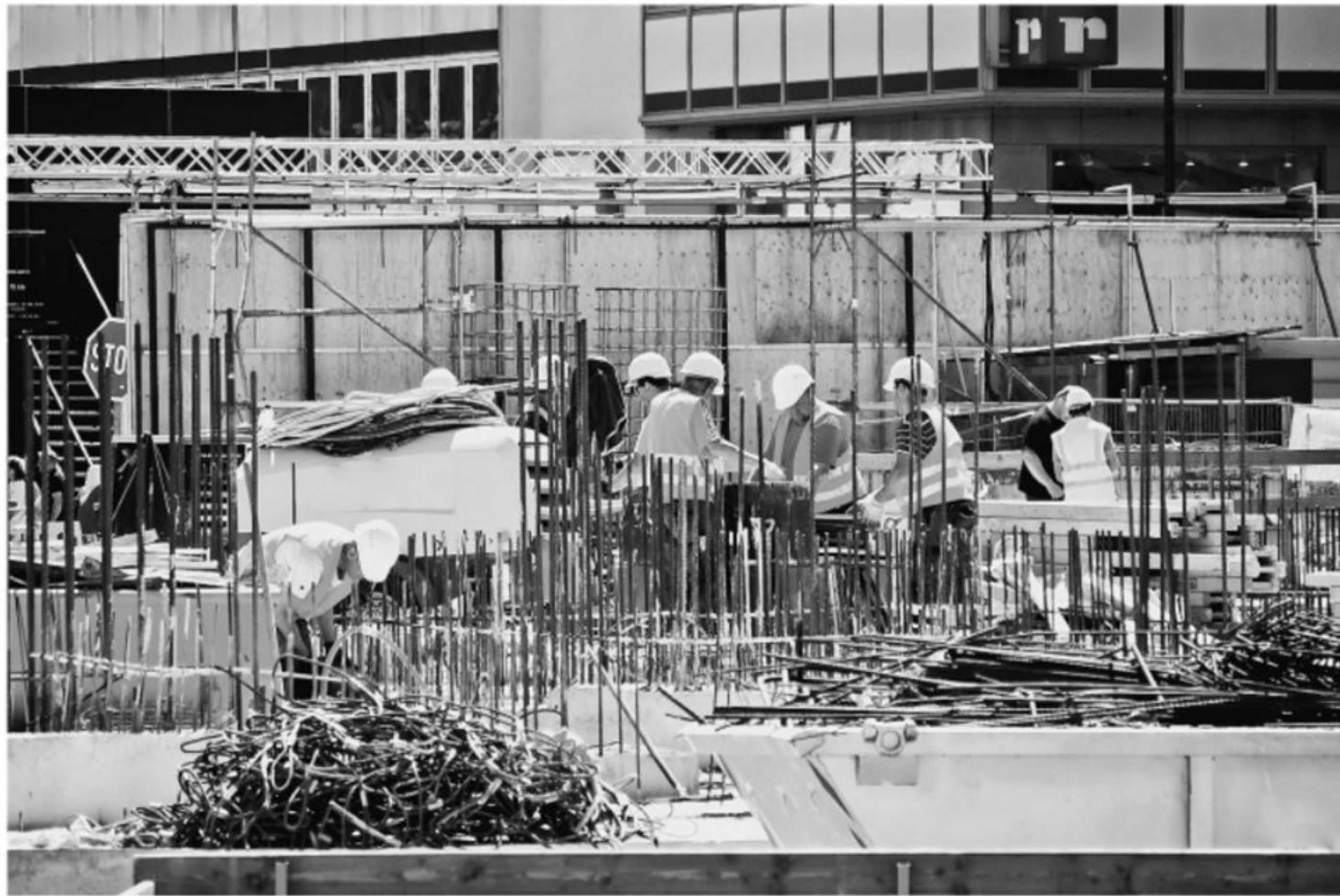
Mit der passenden Software lassen sich alle Abläufe auf der Baustelle digitalisieren.
